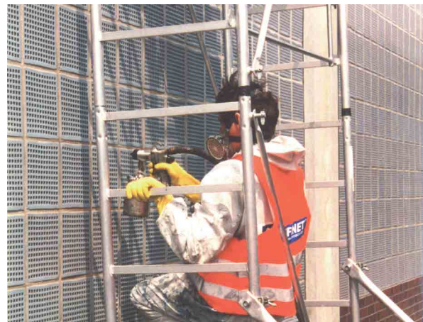
Auftragung von GRAFFINET® 2K-PU-Lack mit dem Spritzgerät.
