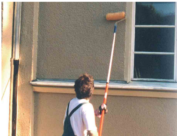
Auftragung von GRAFFINET® 2K-PU-Lack mit der Rolle.
