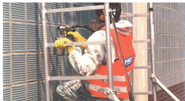
Auftragung von GRAFFINET® 2K-PU-Lack mit dem Spritzgerät.
