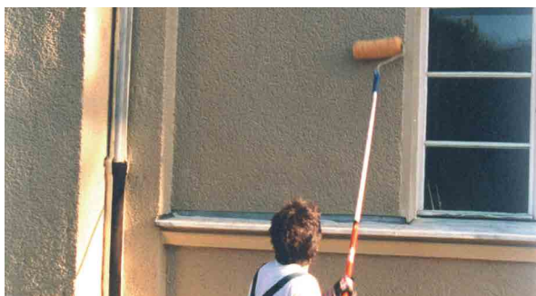
Auftragung von GRAFFINET® 2K-PU-Lack mit der Rolle.
