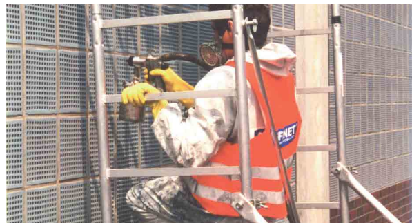
Auftragung von GRAFFINET® 2K-PU-Lack mit dem Spritzgerät.
