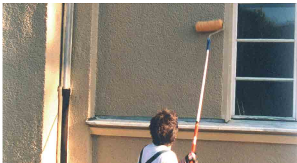
Auftragung von GRAFFINET® 2K-PU-Lack mit der Rolle.
