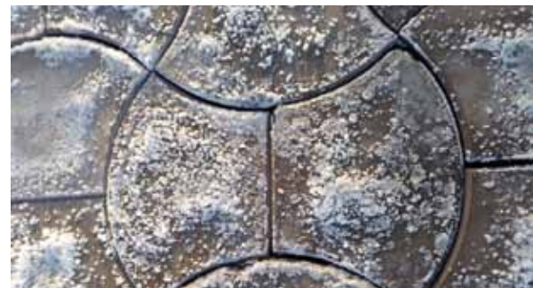
Unschöne Ablagerungen durch Primärausblühungen
