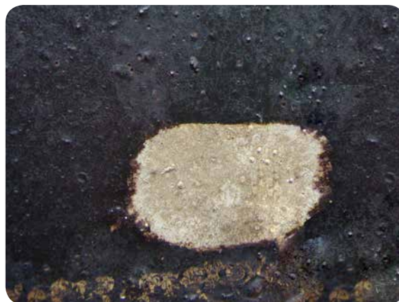
Unterbodenschutz auf Beton: Reinigungsergebnis.
