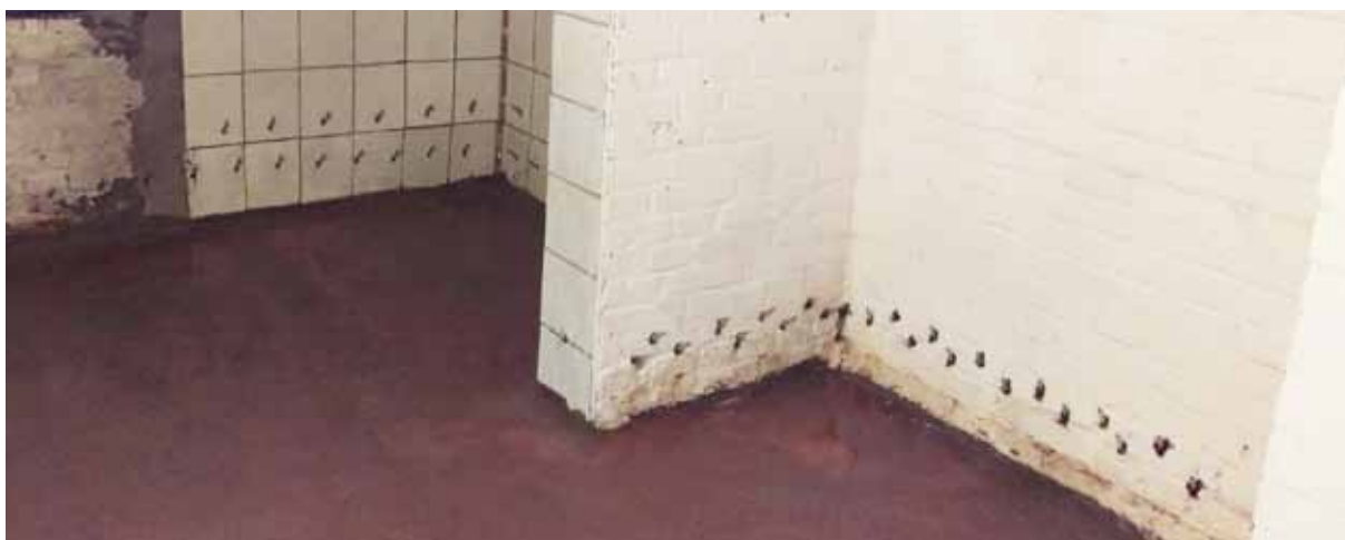
Ansicht eine Horizontalsperre
